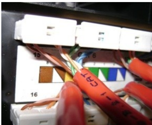
Fig. 3: Exemplo de execução de conectorização no patch panel .
