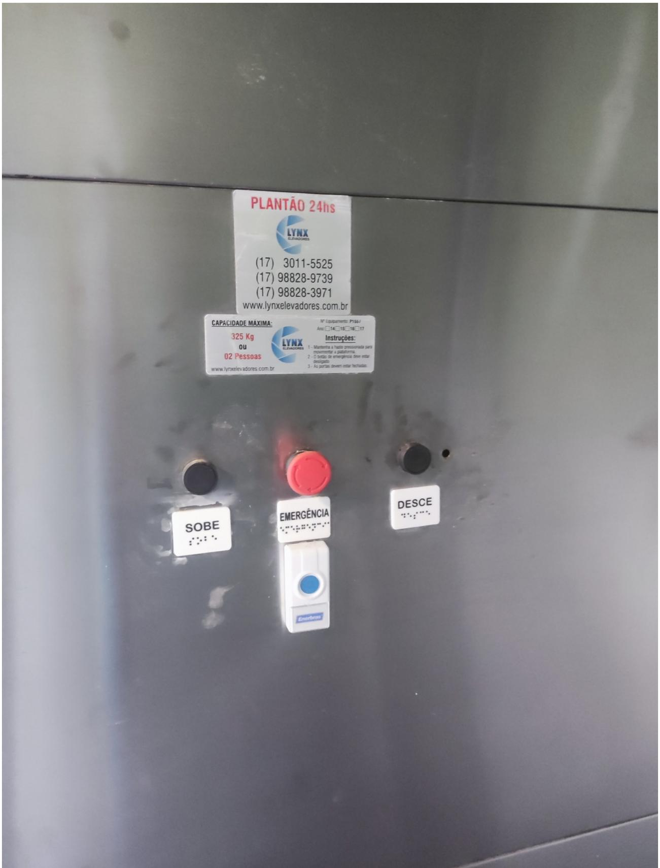
Foto 3. Botoeiras de acionamento pressão constante de subida e descida, e botão de emergência e alarme
