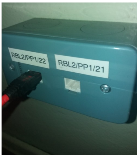
Fig. 7: Ponto de rede x2 devidamente identificado.
