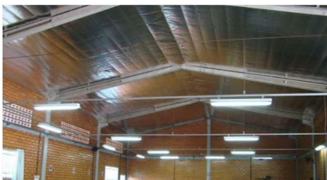
Detalhe Instalação Manta Subcobertura
