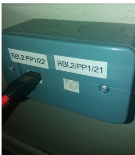
Fig. 7: Ponto de rede x2 devidamente identificado.
