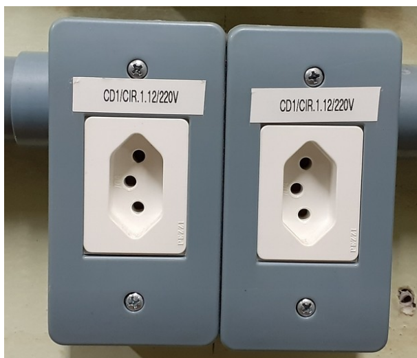
Figura 1 - Exemplo de identificação de tomada.
