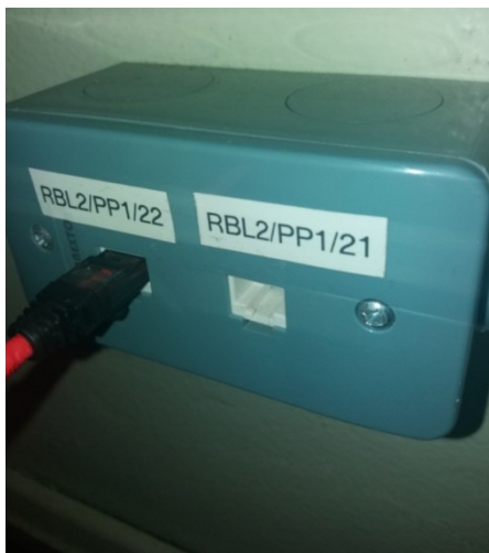
Fig. 7: Ponto de rede x2 devidamente identificado.
