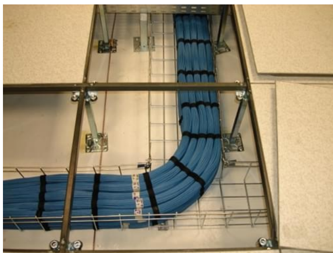
Fig. 6: Detalhe da organização de cabos UTP em leito.
