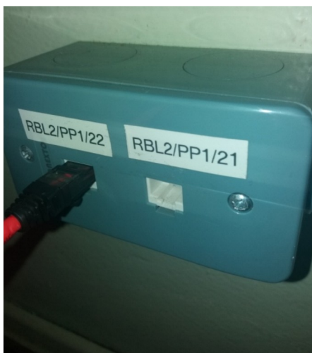
Fig. 7: Ponto de rede x2 devidamente identificado.
